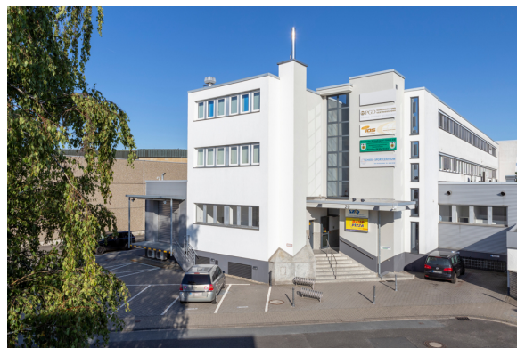
Außenansicht von der Rudolf-Braas-Straße
